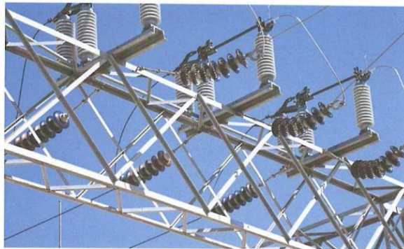
图 5-20 高压输电线路使用了陶瓷绝缘材料
