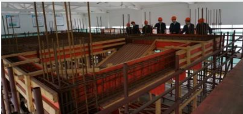
模板、架子实训室
