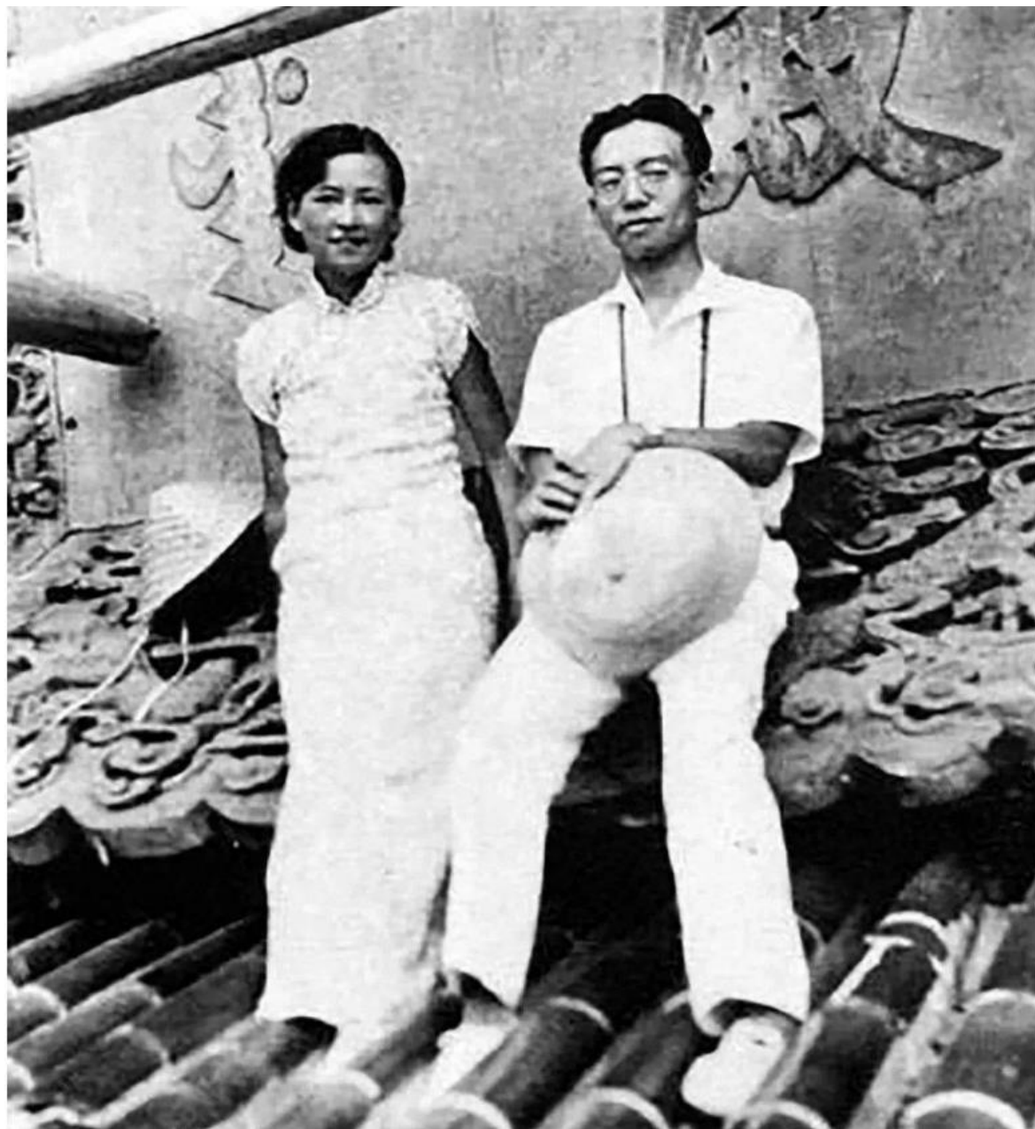
林徽因与梁思成在北平天坛正在修缮的祈年殿屋顶上
